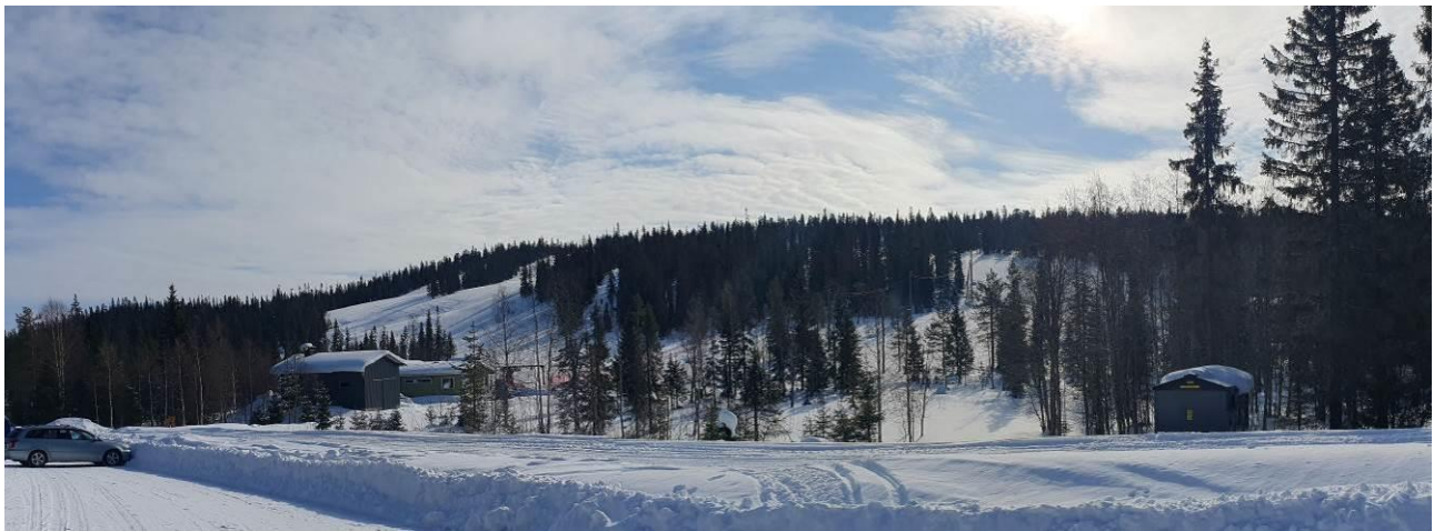
Kuva 8 Kirintövaaran rinnealueita ja huoltorakennuksia
