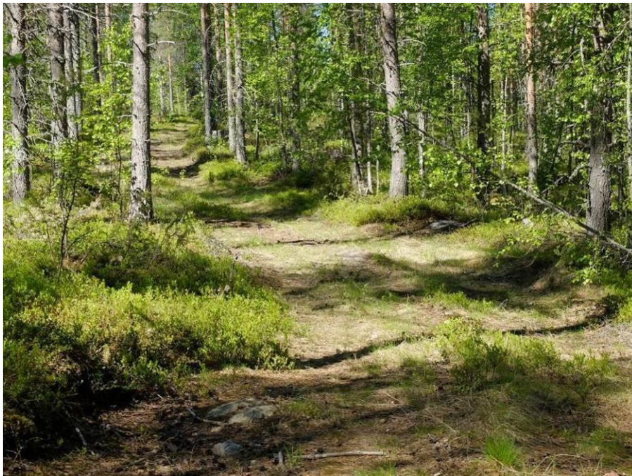
Kuva 16 Tiet vaativat paikoin kunnostamista. Tieura Kattavalammen pohjoispuolella
