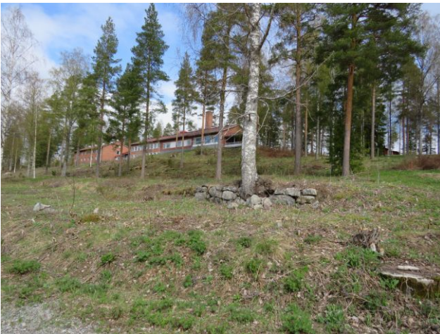
Perustuksen lounaisreuna, kuva pohjoiseen.
