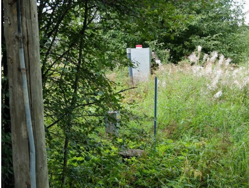
Kuva 16 Jäteveden pumppaamo rannan lähellä
