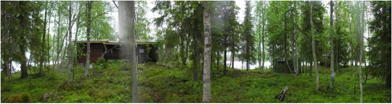
Kuva 10 Korttelin 11 rakennukset idästä kuvattuna
