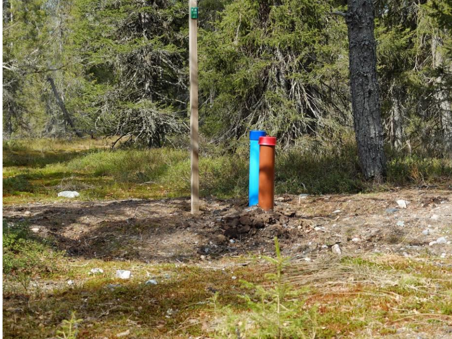
Kuva 22 Alueella on vesi- ja viemäriverkosto valmiina
