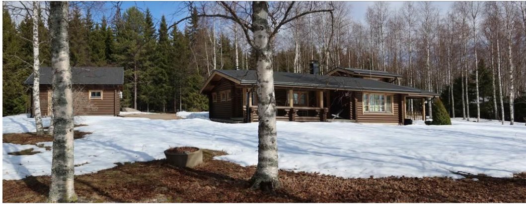
Kuva 8 Kiinteistön 578-404-1-66 rakennuskantaa (Kuvat: Kimmo Mustonen 5.5.2023)
