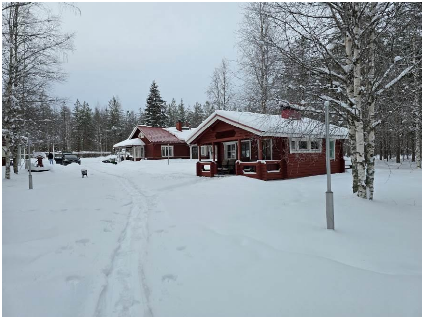
Kuva 15 Rakennukset järven suunnalta
