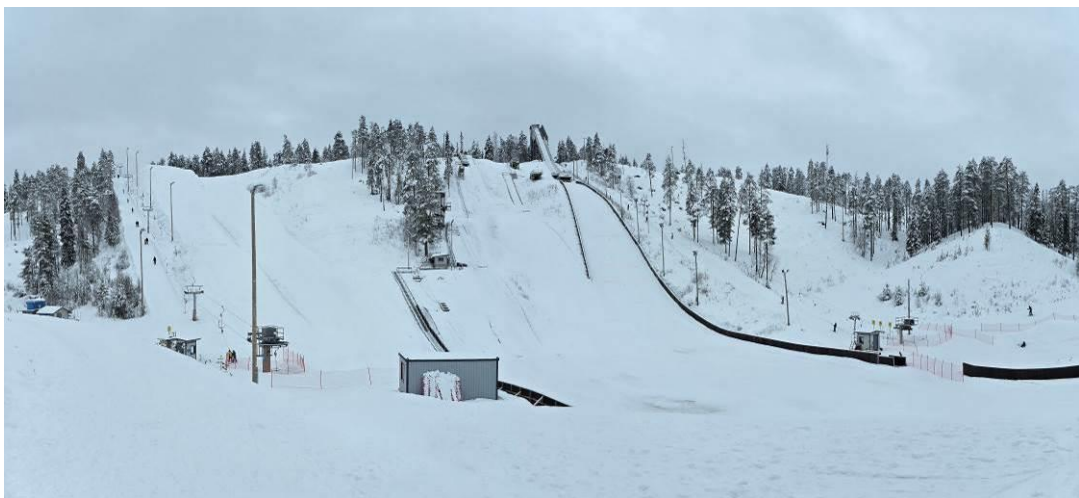
Kuva 19 Taivalvaaran rakennuksia, rakenteita ja rinteitä (Kuvat: Kimmo Mustonen 4.-7.3.2025)
